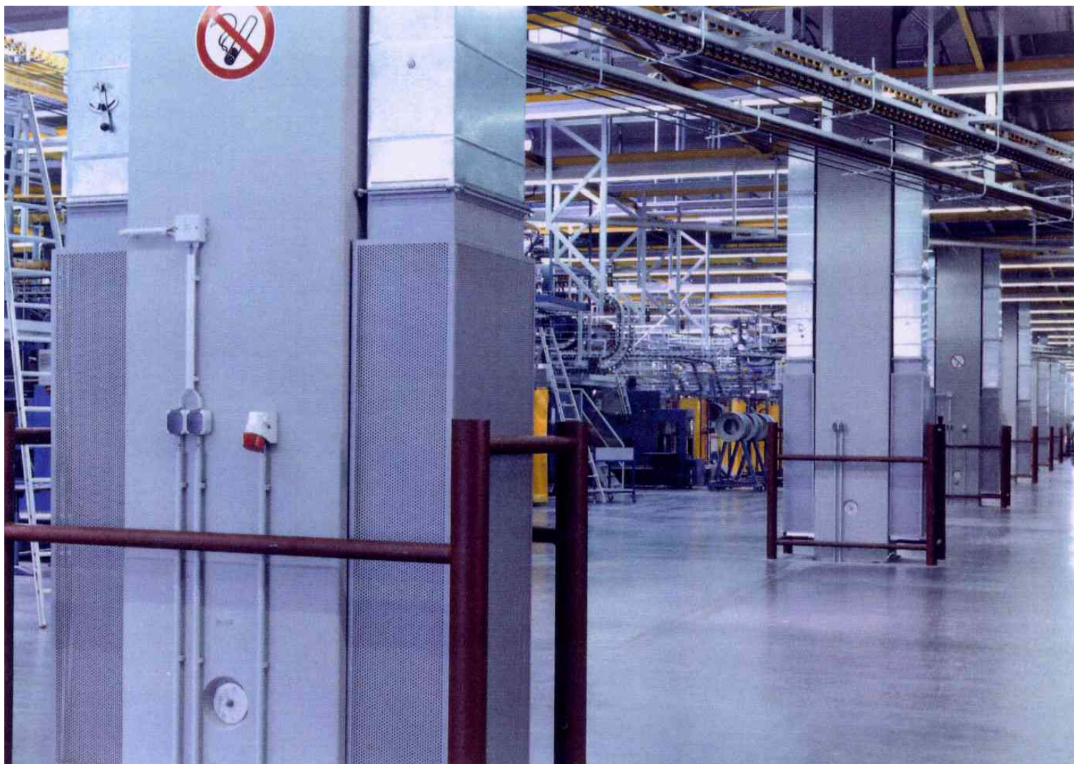
角柱吹出口 の設置例(印 刷工場)
