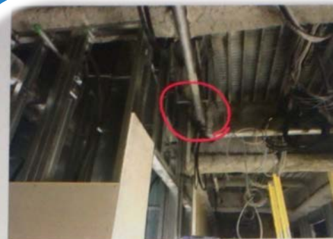
13F北側廊下 貸室1側
