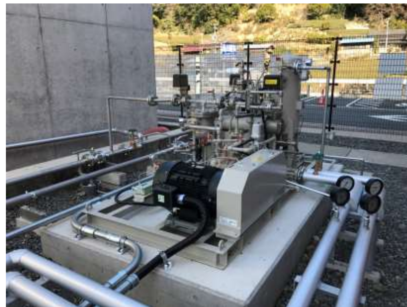
ガスコンプレッサー施工中
