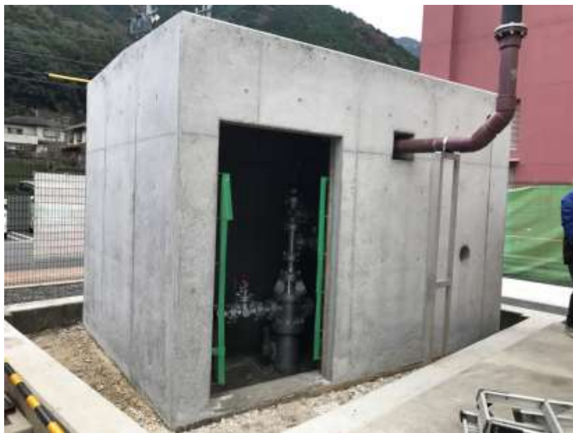
坑口周り施工中
